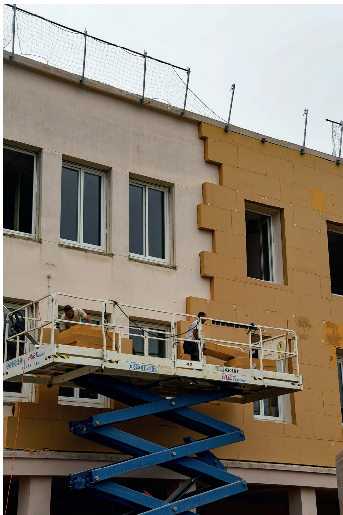
Travaux d'isolation école Herriot
