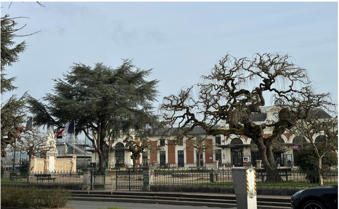
2 – point de vue : le monument aux morts dans le jardin, à l'arrière la façade de la gare constitue le fond de scène du monument. Source : G.Duhamel
