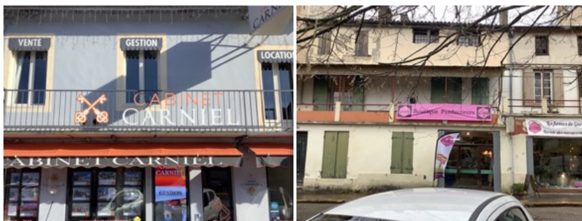
Enseignes sur garde-corps de balcon ou balconnet, Marmande, Novembre 2023.
