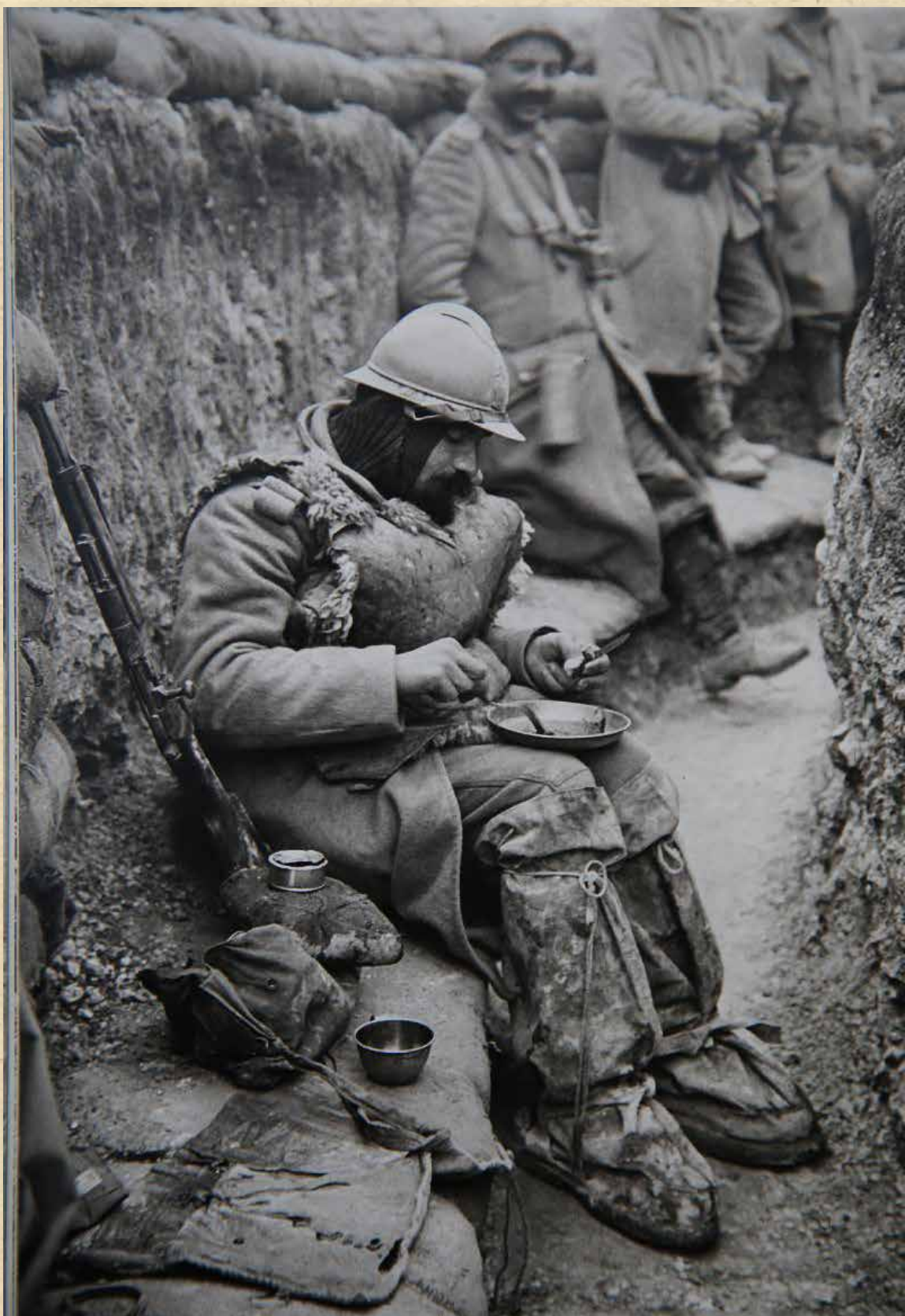
Un repas dans la tranchée.
