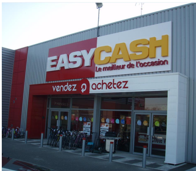
Enseigne en lettres découpées sur bandeau
