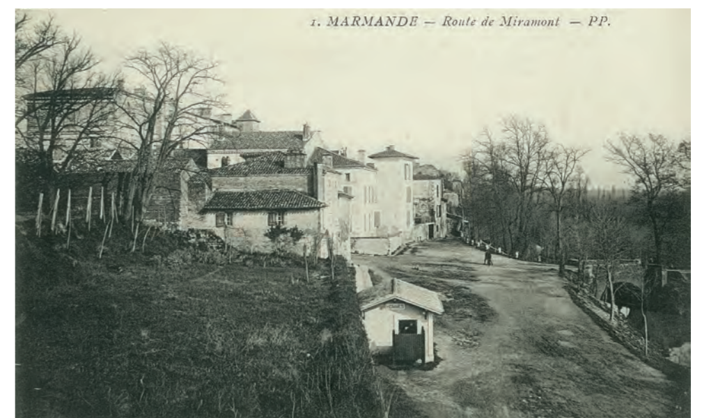
Débouché rue de la Filhole
